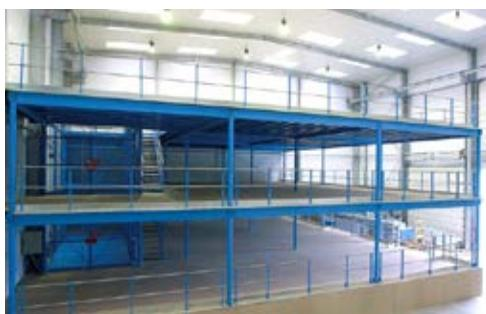
Il s'agit d'une barrière de protection qui permet au personnel d'être protégé des zones à risque et d'éviter les chutes de hauteur. Sur-mesure ou standard, le garde-corps s'adapte aux différentes contraintes des bâtiments.
